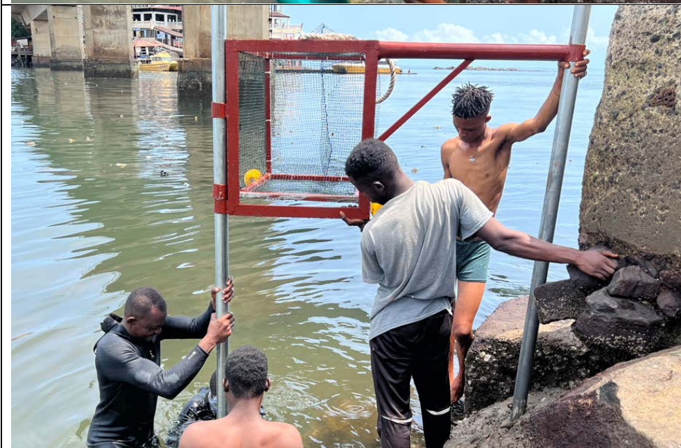
Installation af rør, så kurven kan køre op og ned.
