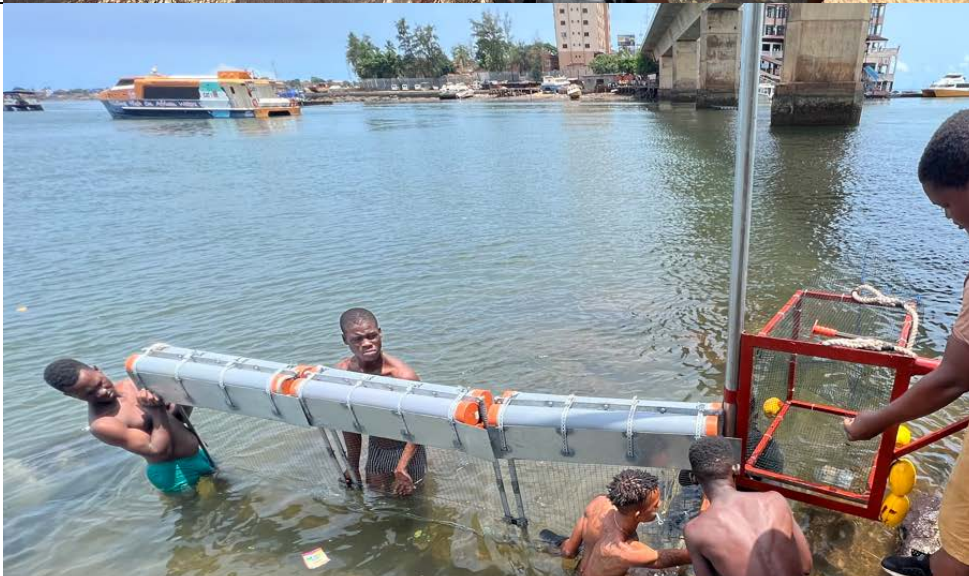
Installation af barrieren.
