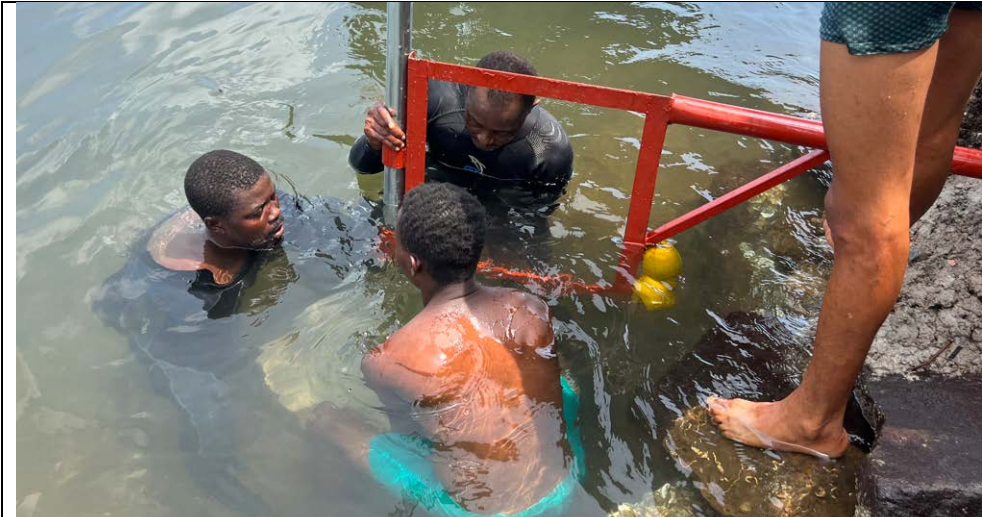
Installation af rammen.
